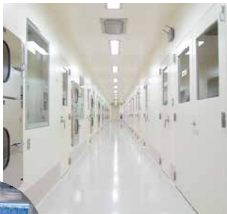
クリーンルーム通路 Access corridor to clean rooms
